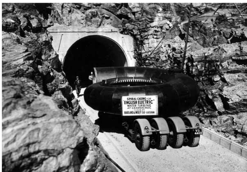
Joonis 4.3. Spiraalkanali transportimine turbiini saali läbi juurdepääsu tunnelit.
